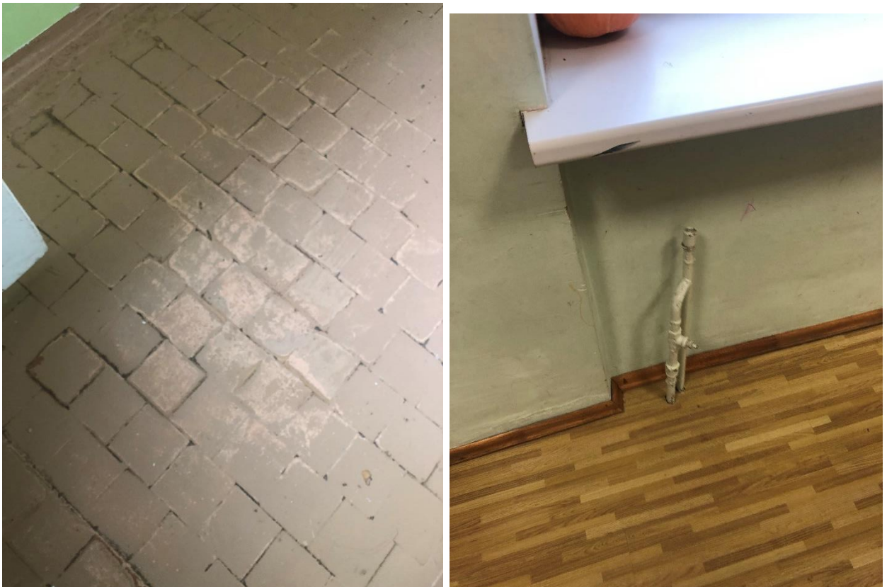
7 pav. Grindų danga ant neapšiltintos grindų konstrukcijos
