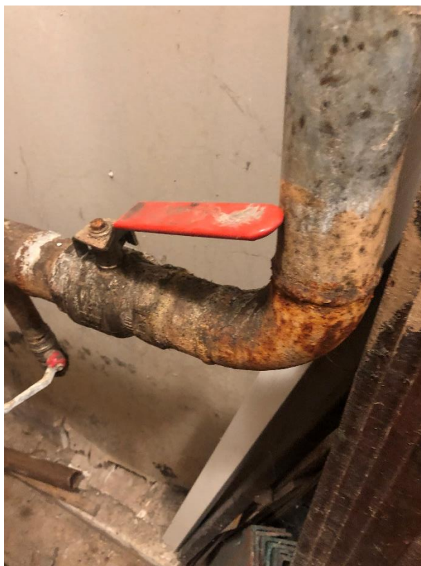
10 pav. Neapšiltinti susidėvėję vamzdynai
